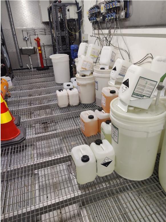
Kuva 7. Erään pesulan allastettu kemikaalivarasto.
