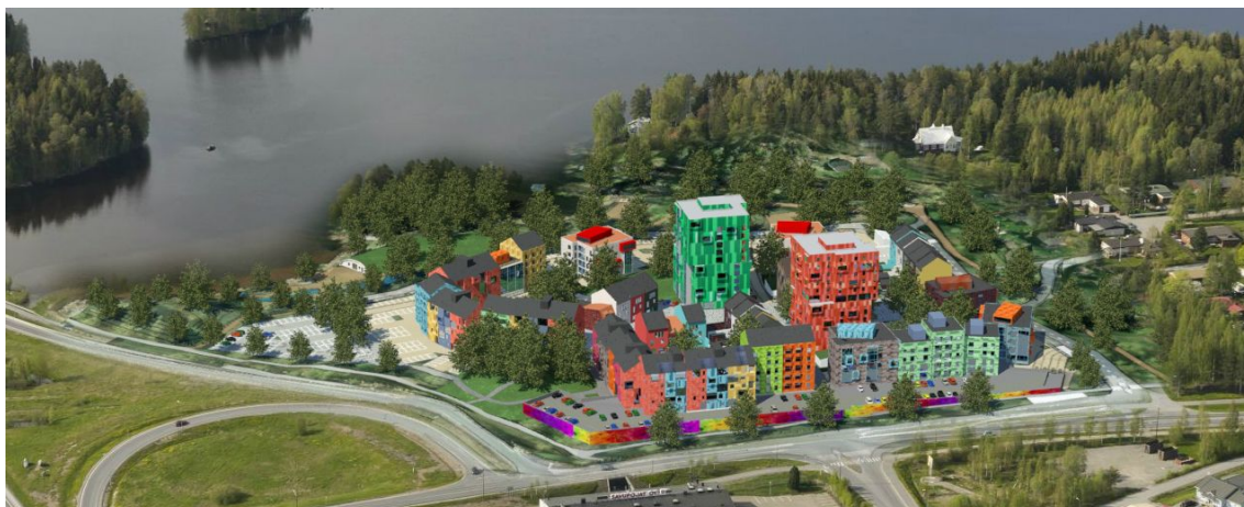
Kuva 29, Alue kuvattuna etelän suunnasta. Ilmakuva, Lentokuva Vallas Oy 2012, malli ja upotus, Pirkkalan maankäyttö 2016.
