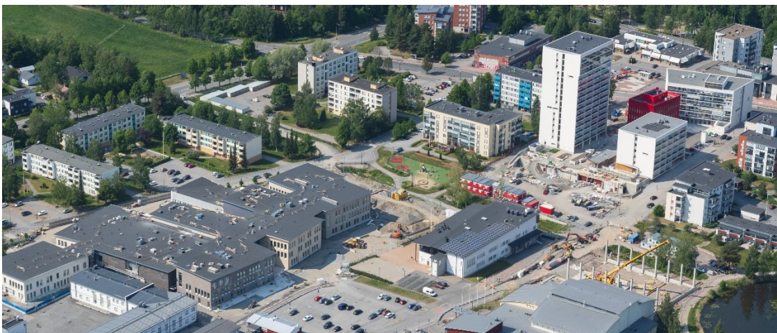
Kuva 8. Kuvassa rakenteilla oleva koulukampus ja keskustakortteli. Pirkkalan kunta, Suomen Ilmakuva Oy 2023.
